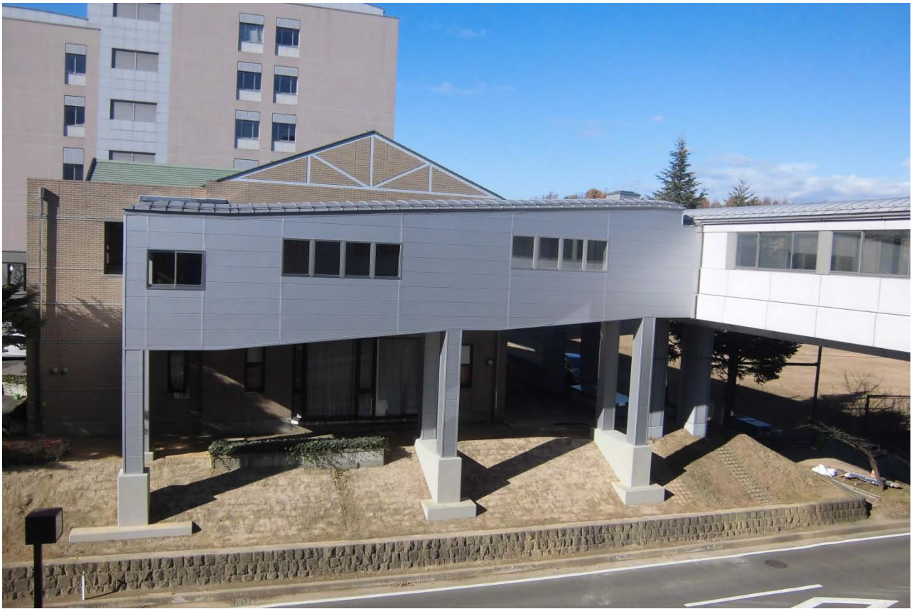
【渡り廊下東側外観】
