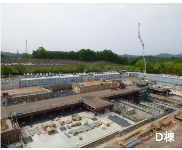
D棟では、建物の基礎部分を作るための鉄筋工事と、コンクリート工事を進めています。
