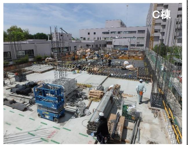
C棟では、地下部分、1階部分の床・壁・柱を作るための鉄筋工事、型枠工事を引き続き行っています。
