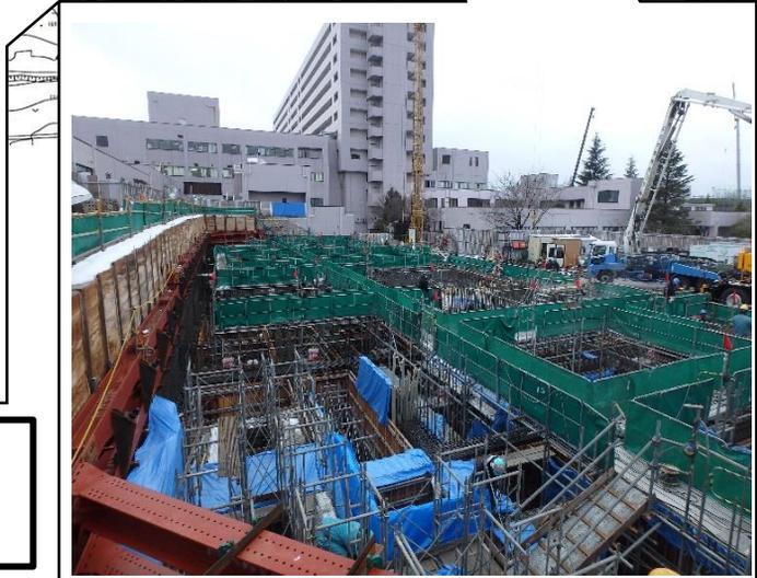
C棟では、建物の基礎となる床や柱の骨組みを作る鉄筋工と、コンクリートを流し込むための枠を作る型枠工を行っています。
