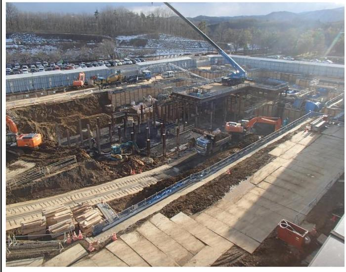
D棟では、建物の基礎部分を作るために、土砂を掘り出す掘削工と、掘削面の地盤崩壊を防ぐ山留工を引き続き行っています。
