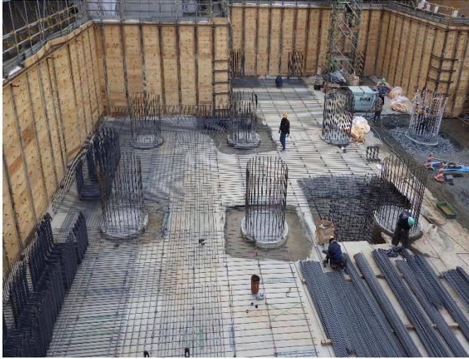
B棟では、柱となる部分の骨組みを作る鉄筋工事と、コンクリートを流し込むための枠を作る型枠工事を行っています。
