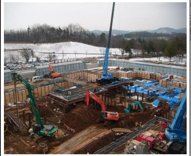
D棟では、建物の基礎部分を作るために、土砂を掘り出す掘削工事と、掘削面の地盤崩壊を防ぐ山留工事を引き続き行っています。
