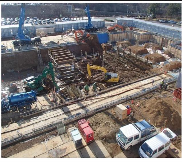
D棟では、建物の基礎部分を作るため、地盤を掘る掘削工事と、掘削した部分の地盤崩壊を防ぐ山留工事を行っています。
