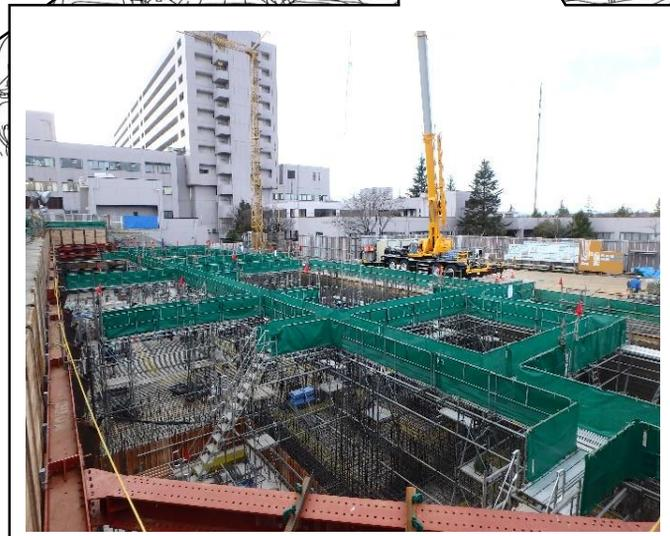
C棟では、床や柱の骨組みを作る鉄筋工事を行っています。
