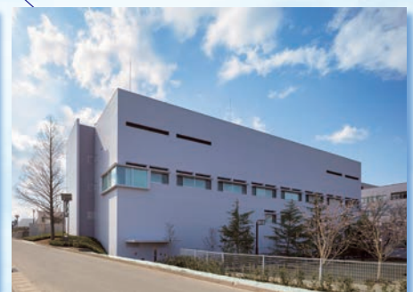
先端臨床研究センター棟
