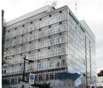
保健科学部新校舎建設状況 ※10月20日現在
