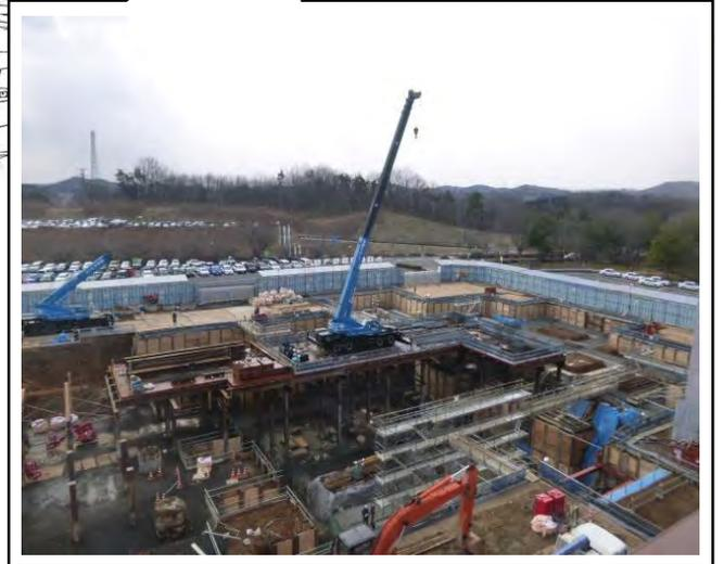
D棟では、建物の基礎を作るため、土砂を掘り出す掘削工と、掘削が完了したところから鉄筋工、コンクリート工を進めています。
