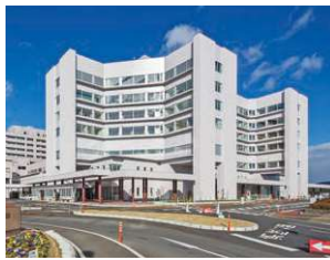
ふくしま いのちと未来のメディカルセンター棟
