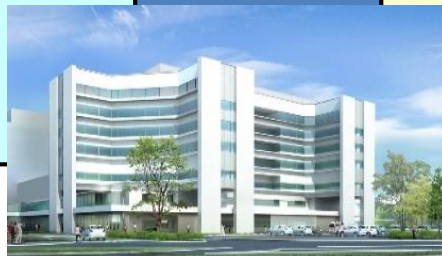
ふくしまいのちと未来のメディカルセンター棟
