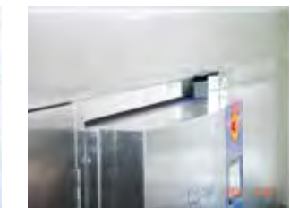
写真4 低温ガス滅菌装置の前方手前へのズレ(左)によるステンレス化粧パネルの剥離(右)。
