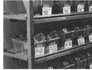
写真8 ステンレス角棒による飼育架台のケージ落下防止策 (2000年4月に対応済)。
