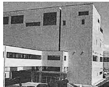
写真1 JST事業によって増築した動物施設(右側建物の1階・3階部分)と渡り廊下(手前)、左側は従来の動物施設。
