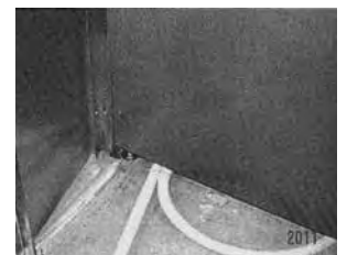
写真4 低温ガス滅菌装置の前方手前へのズレ(左)によるステンレス化粧パネルの剥離(右)。
